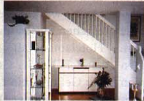
VORHER NACHHER Aus der „normalen“ Holztreppe wurde eine fast freitragende Konstruktion
