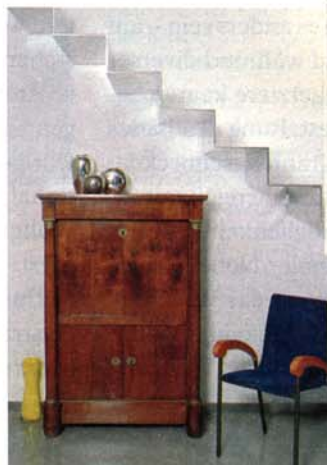
VORHER NACHHER Aus der „normalen“ Holztreppe wurde eine fast freitragende Konstruktion
